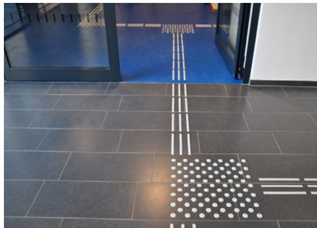
Abb. 9 Bodenindikatoren am Beispiel aufgeklebter Rippen und Noppen
