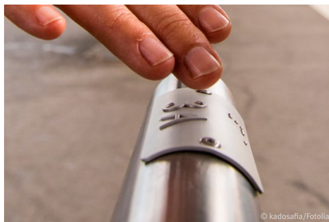
Abb. 11 Taktile Information am Handlauf sowohl über Braille- als auch über Reliefschrift
