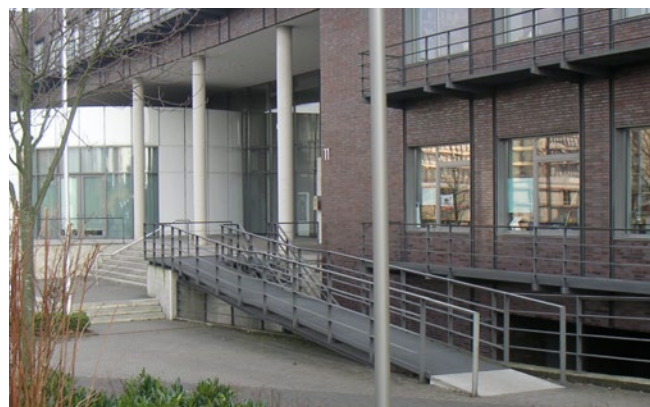
Abb. 4 Rampe im Außenbereich mit Gitterrostbelag
