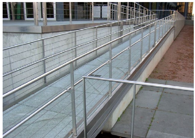
Abb. 7 Rampe im Außenbereich mit Betonplattenbelag
