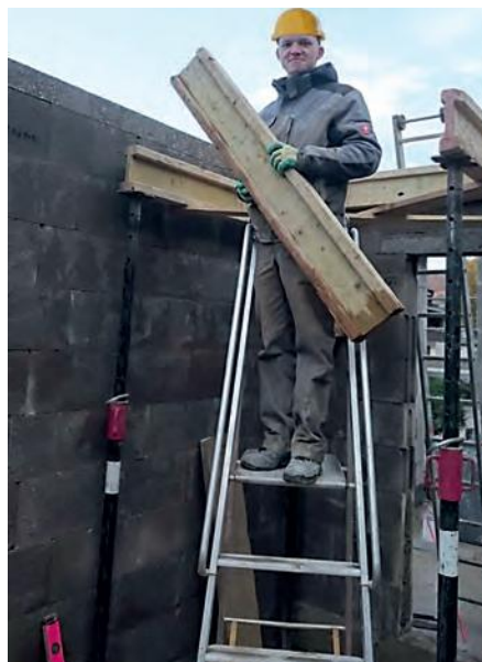
Abb. 6: Aufstellen der Deckenjoche zur Aufnahme von Filigrandeckenelementen
