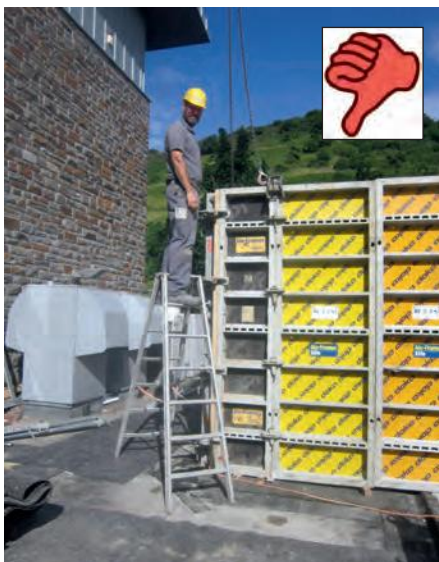
Abb. 1–3: Unzulässige Nutzung der beiden obersten Stufen/Sprossen bei Stufen- und Sprossenstehleitern (Fotos: BG BAU)
