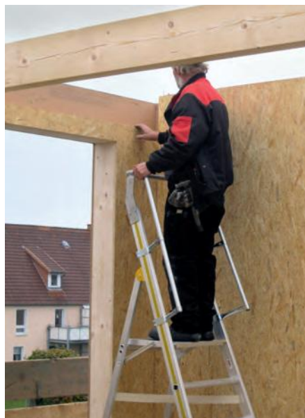
Abb. 9: Montagearbeiten auf einer Fertighausbaustelle
