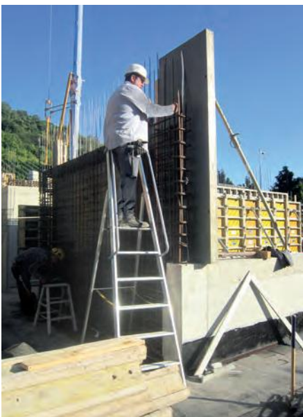
Abb. 5: Ausführung von Bewehrungsarbeiten unter Einsatz einer leichten Plattformleiter
