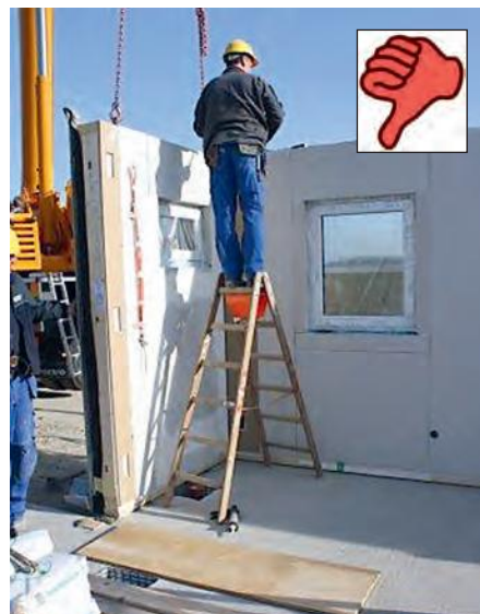
Abb. 1–3: Unzulässige Nutzung der beiden obersten Stufen/Sprossen bei Stufen- und Sprossenstehleitern (Fotos: BG BAU)
