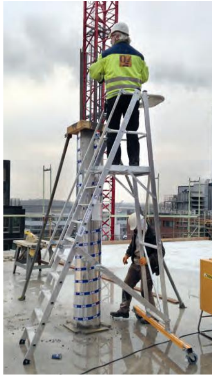
Abb. 4: Einsatz einer Podestleiter zur Herstellung von Ortbetonstützen (Foto: BG BAU)
