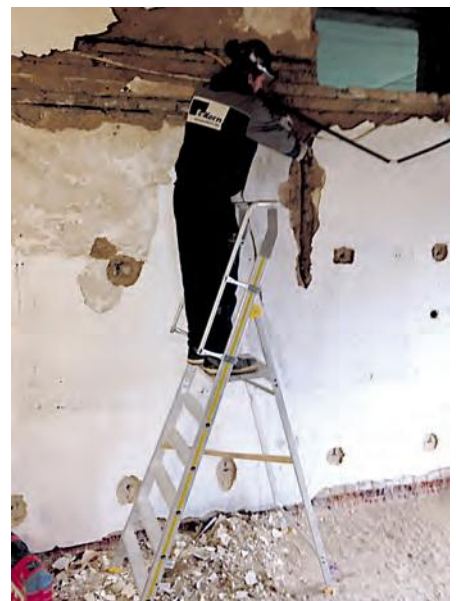
Abb. 10: Abbrucharbeiten – händische Entkernung – Einsatz leichte Plattformleiter (Fotos 8–10: BG BAU)
