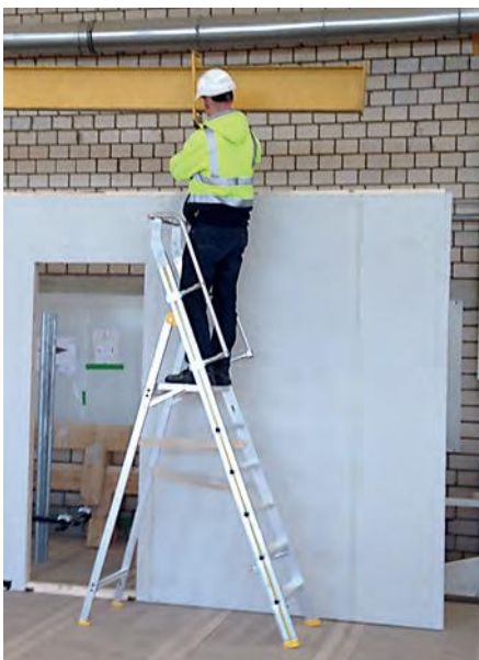
Abb. 8: Abschlagen von Anschlagmitteln bei der Zwischenlagerung von Holzrahmenfertigteilen
