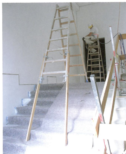
Abb. 1: Nachgestellte Unfallsituation mit der Stehleiter – die Spreizsicherung ist nicht vollständig gespannt, das Malerabdeckvlies auf der Treppe nicht bzw. unzureichend fixiert – Gefahr des Absturzes auf der unteren Seite, hier gibt es ausziehbare Leitern mit Sprossen und rutschsicheren Fußkappen
