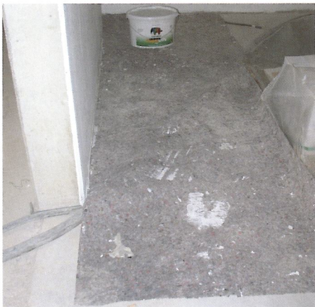
Abb. 3: Überdecktes Stromkabel
