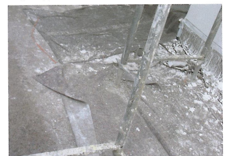
Abb. 2: Faltenbildung und aufgeklappte Stöße
