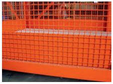
Abb. 9: Seitenschutz bis mindestens 0,5 m Höhe aus Drahtgeflecht (oder Lochblech, Vollblech)
