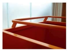
Abb. 10: Handlauf zur Vermeidung von Quetschgefahren
