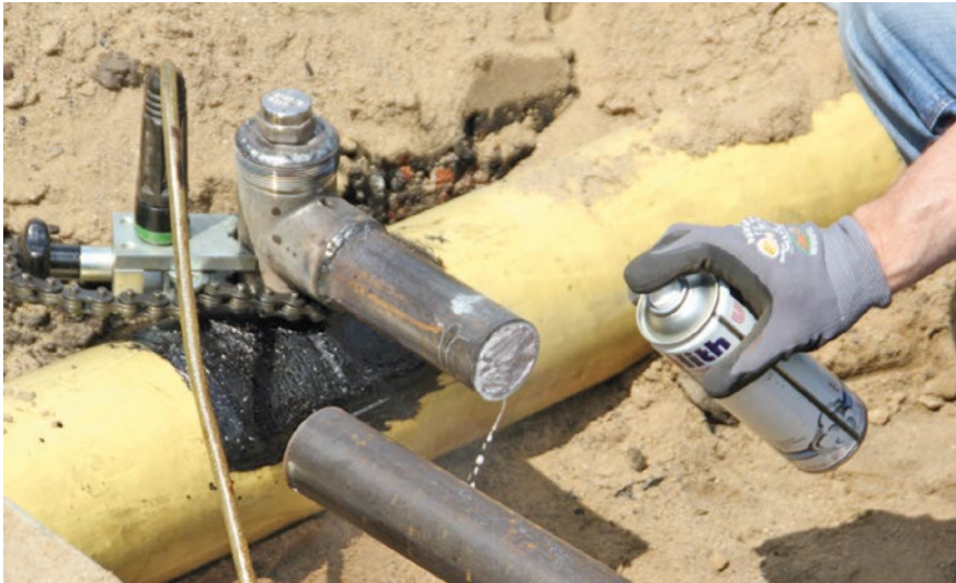
Abbildung 6: Kontrollprüfung auf Schaumdichtigkeit nach Trennung der Stahlleitung direkt vor dem Bohrloch
