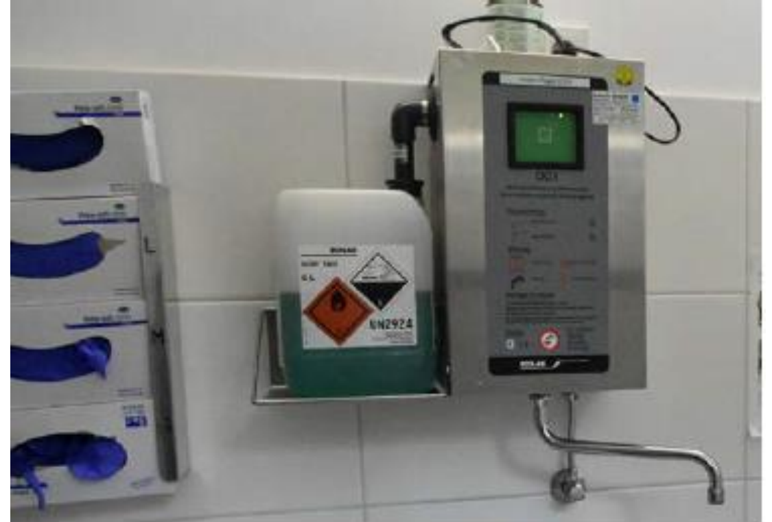
Abb. 10 Technische Lösung für die Entnahme eines gebrauchsfertigen Desinfektionsmittels
