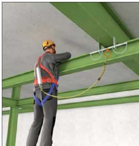
Abb. 3: Beispiel eines Auffangsystems mit Falldämpfer an einer temporären Anschlag-einrichtung (Trägerklemme)
