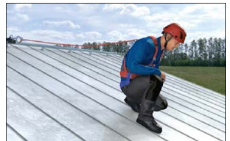
Abb. 1: Beispiel für ein Rückhaltesystem mit fester Länge, befestigt an einer dauerhaft am Objekt befestigten Anschlageinrichtung mit einem beweglichen Anschlagpunkt
