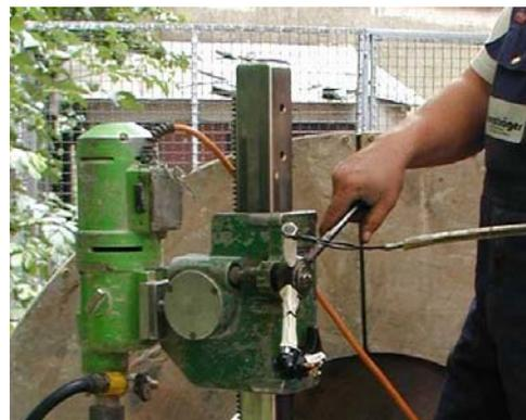
Abbildungen: Erstellung von Kernbohrungen mit und ohne Führungsgestänge
