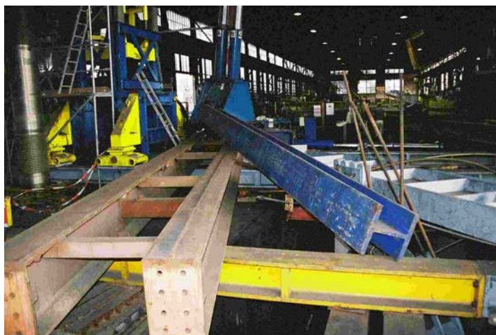
Abbildung 2-29: Unfallsituation an einem Hubgerüst
