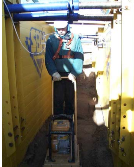
Abbildung 2-13: Messung von Abgasexpositionen beim Grabenbau
