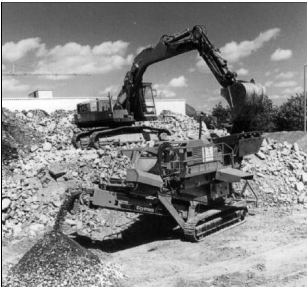
Abbildung 15: Anlagenbeschickung mit Bagger
