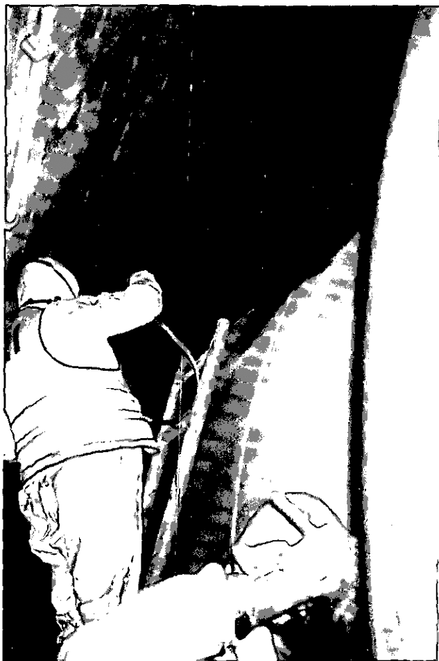
Abbildung 54: Beschichtung „Airless“ spritzen (E 83)
