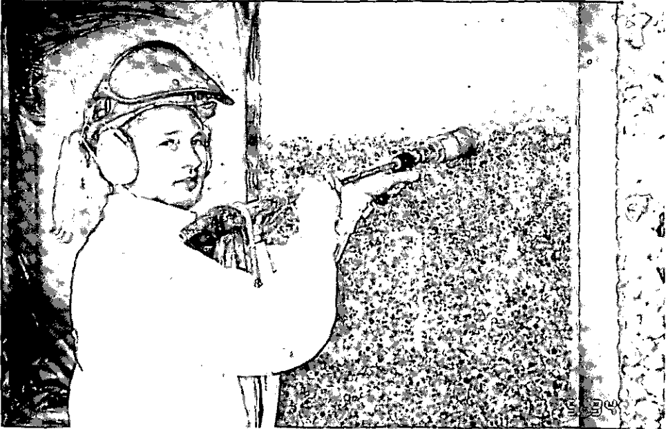
Abbildung 51: Alte Fassadenbeschichtung durch Hochdruckwasserstrahlen entfernen (E 79)
