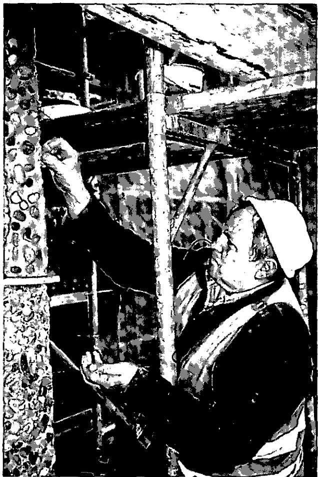
Abbildung 47: Fehlstellen der Wasch- betonfassade ausbessern (Grobarbeit) (E 72)
