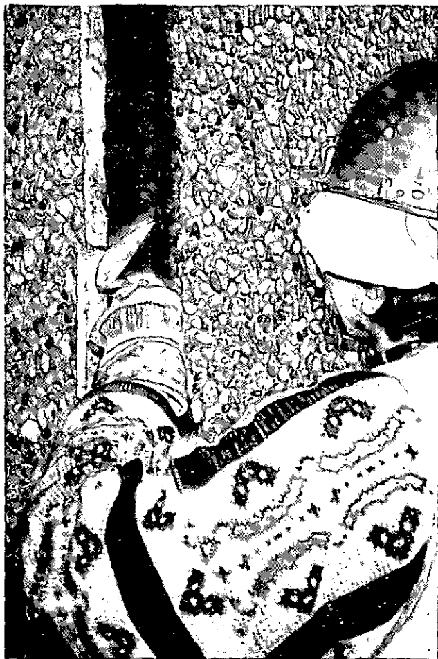
Abbildung 48: Fehlstellen der Wasch- betonfassade ausbessern (Grabarbeit) (E 72)
