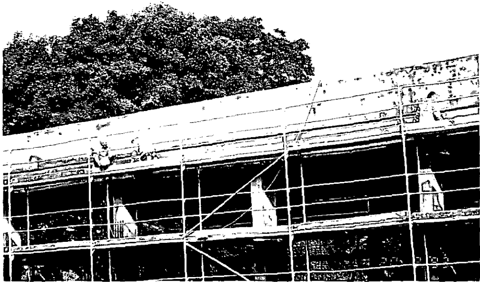
Abbildung 32: Beschichtung auftragen (Glättkelle) (E 46)
