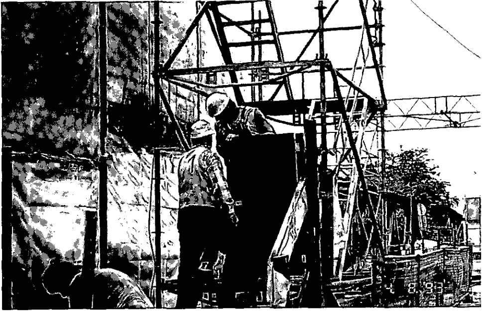
Abbildung 25: Umbau der Strahlereinhausung (E 30)
