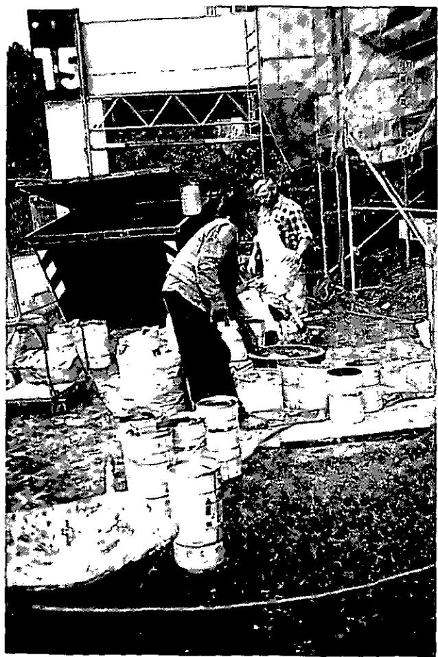
Abbildung 35: Beschichtungsmaterial anrühren (E 53)
