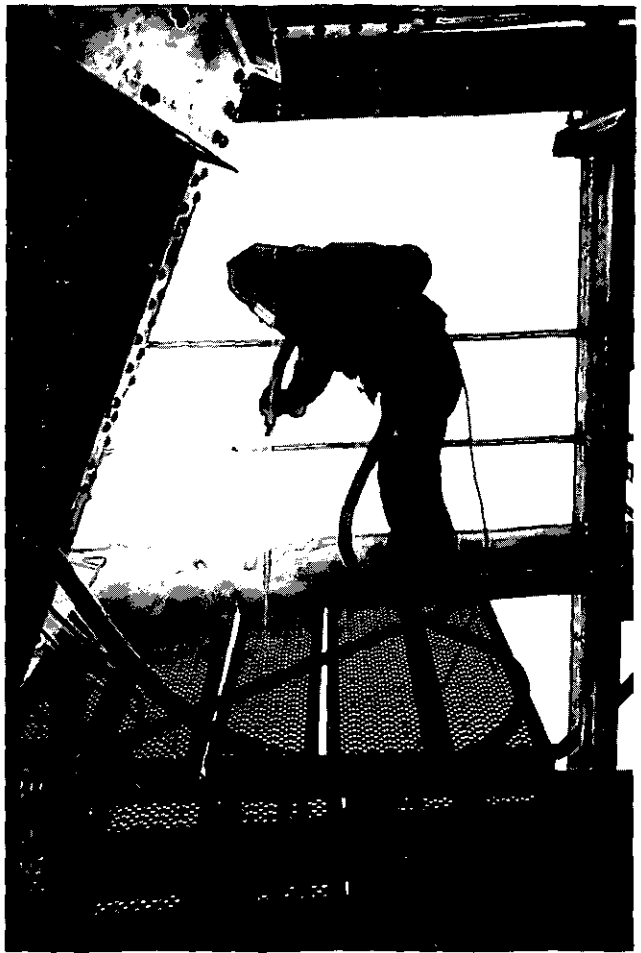
Abbildung 40: Strahlreste abblasen (großer Schlauch => hohe Leistung) (E 63)
