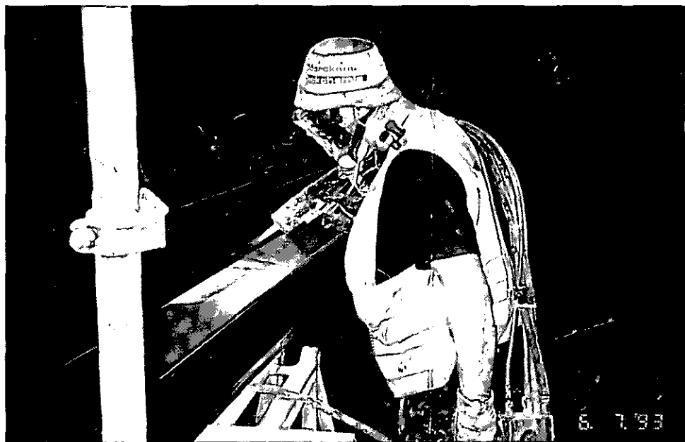
Abbildung 22: Spritzverzinken (E 19)
