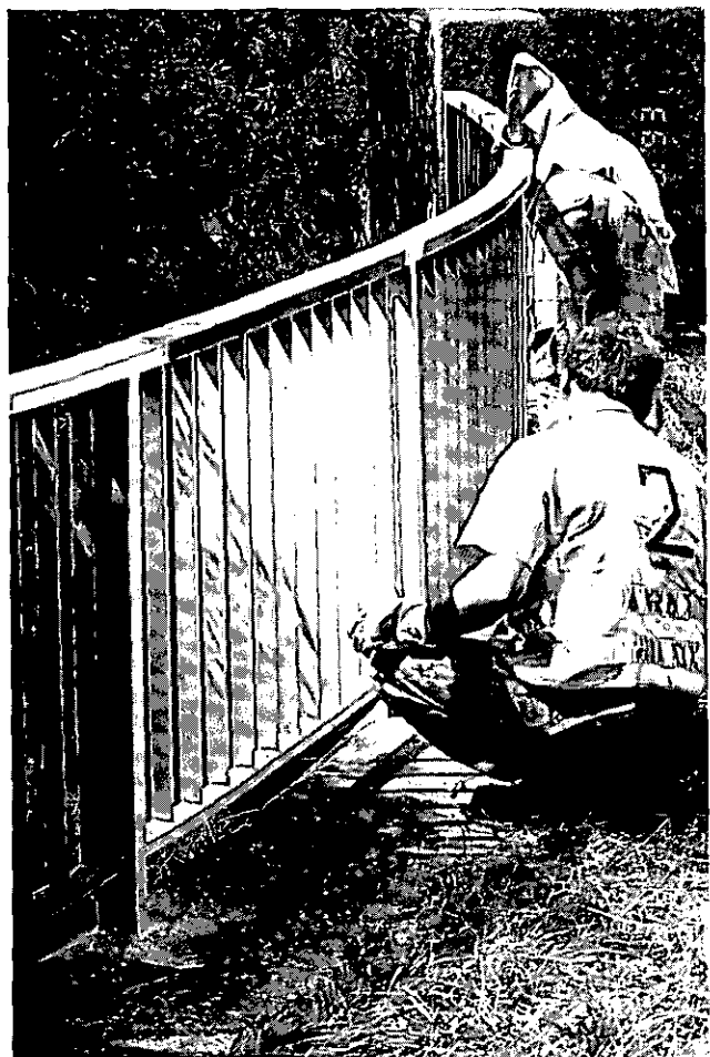
Abbildung 24: Beschichten eines Geländers (E 24)
