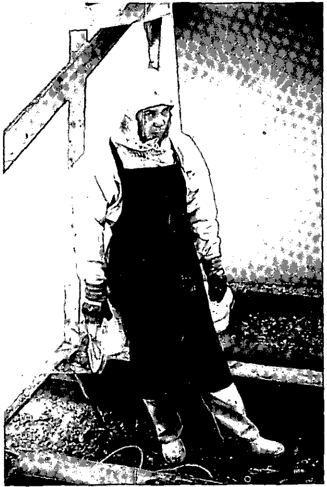
Abbildung 50: Abstrahlen der Betonrippen einer Brücke (E 77)
