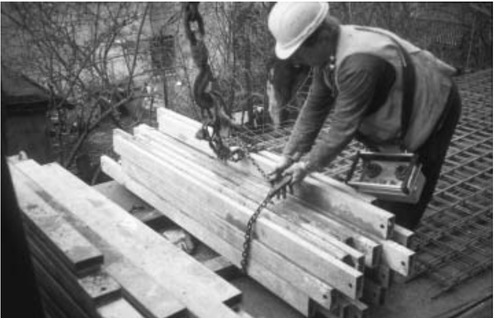
Abbildung 29: Material anschlagen (B19)
