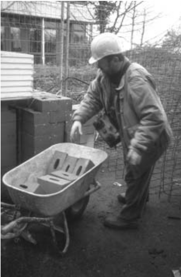
Abbildung 25: Turmdrehkranführer lädt Steine zum Transport in eine Schubkarre (B 12)
