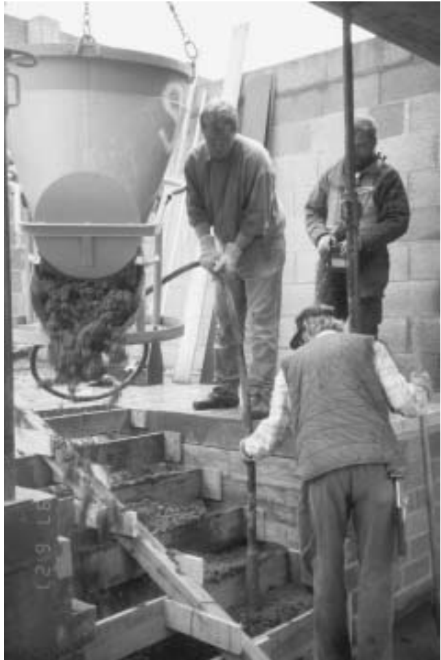
Abbildung 39: Treppe im Inneren des Gebäudes mit ferngesteuertem Turmdrehkran betonieren (B 31)
