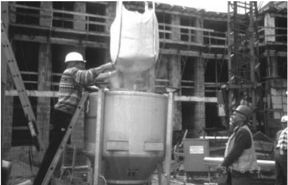
Abbildung 35: Mörtelbehälter mit ferngesteuertem Turmdrehkran befüllen (B 27)
