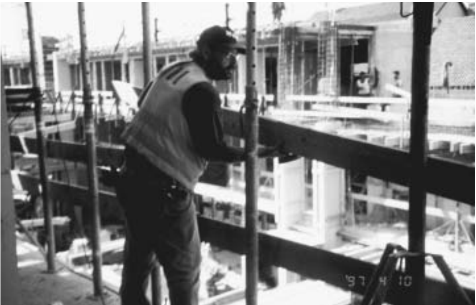
Abbildung 34: Holzgeländer umbauen (B 26)
