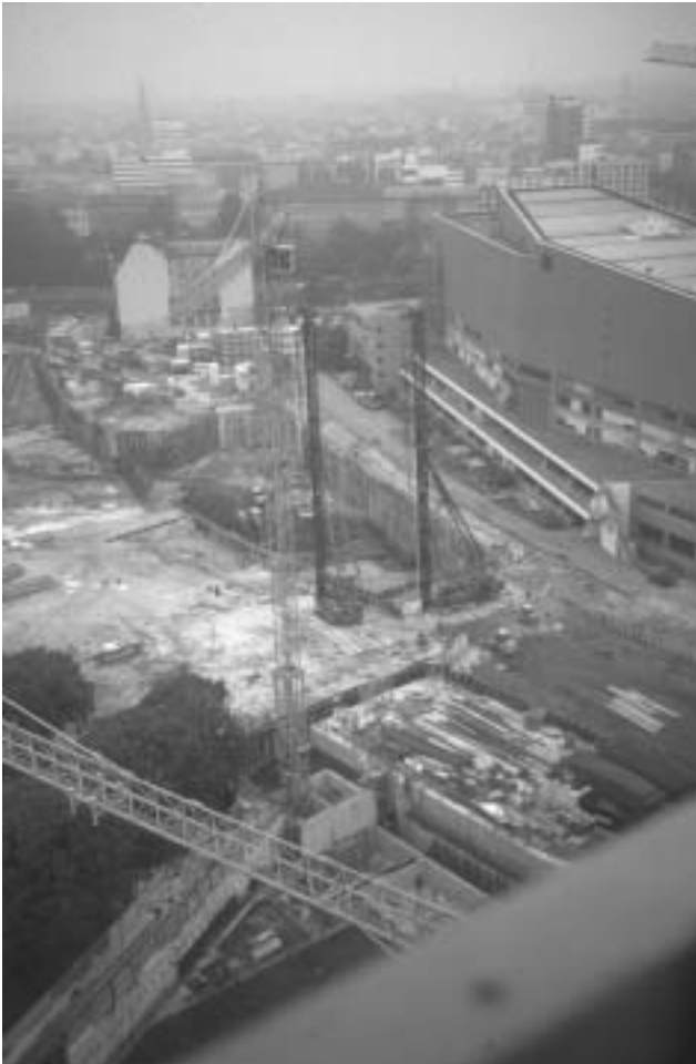
Abbildung 21: Blick auf den Arbeitsplatz von Turmdrehkranführer B 8
