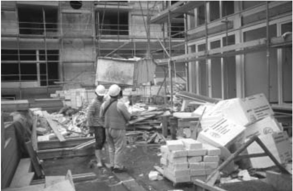
Abbildung 42: Schuttmulde mit ferngesteuertem Turmdrehkran transportieren (B 34)
