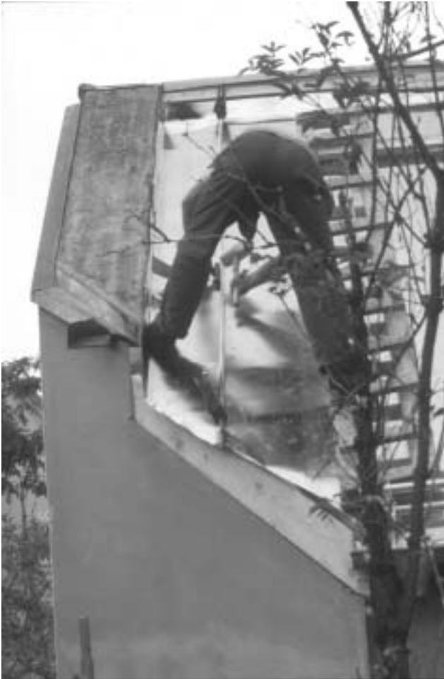
Abbildung 14: Blechschar einpassen (A 4)
