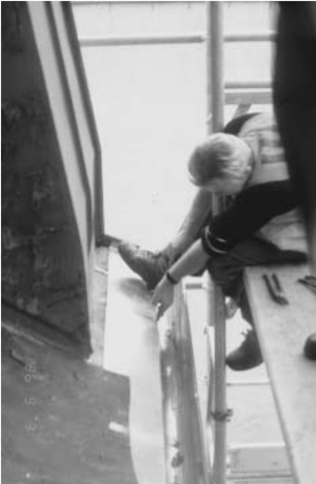
Abbildung 13: Montage der neuen Dachrinne (A 3)
