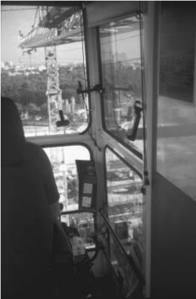
Abbildung 23: Turmdrehkran steuern (B 10)
