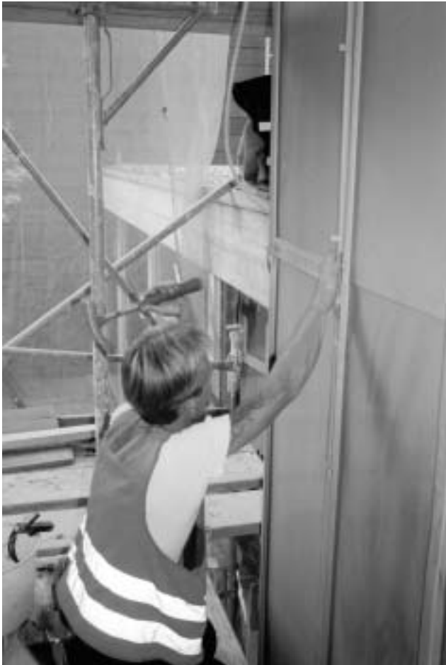
Abbildung 31: Falze mit Handhammer schließen (A 31)
