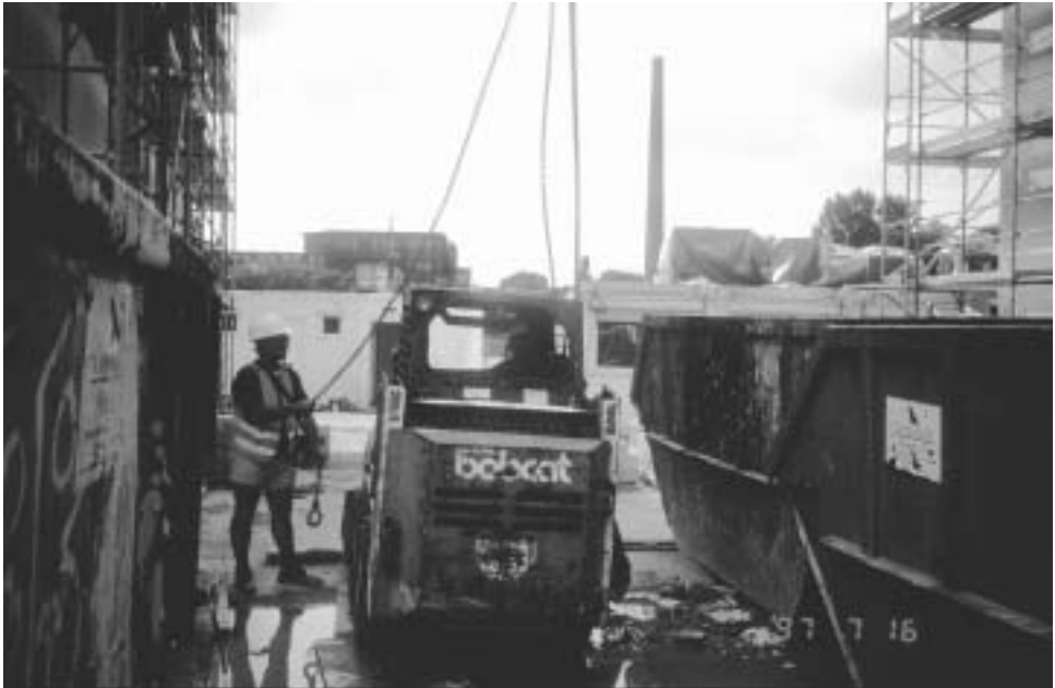
Abbildung 43: Kompaktlader anschlagen (B 35)
