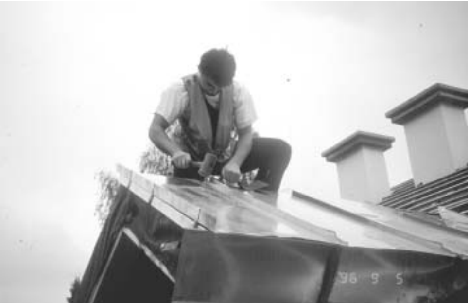
Abbildung 17: Gaube einblechen (A 8)
