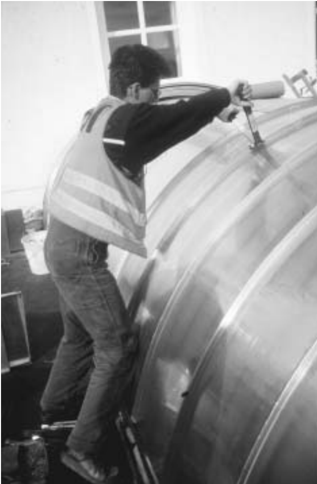
Abbildung 24: Blechfalze mit Falzzange schließen (A 18)
