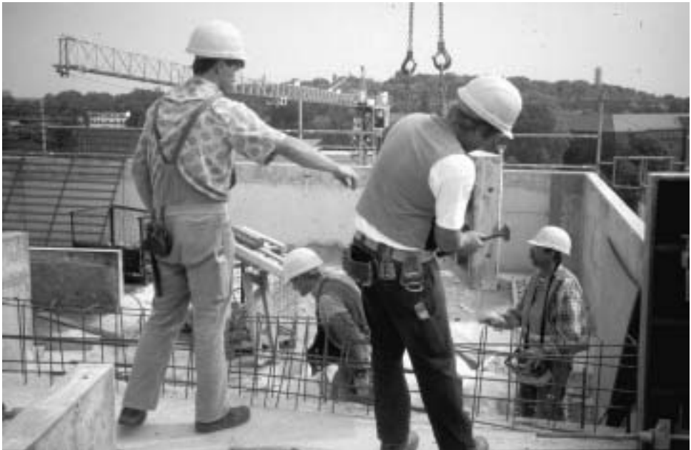
Abbildung 18: Schalelemente mit ferngesteuertem Turmdrehkran transportieren (B 2)
