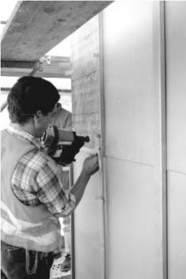
Abbildung 30: Hafler mit Druckluftnagler annageln (A 30)
