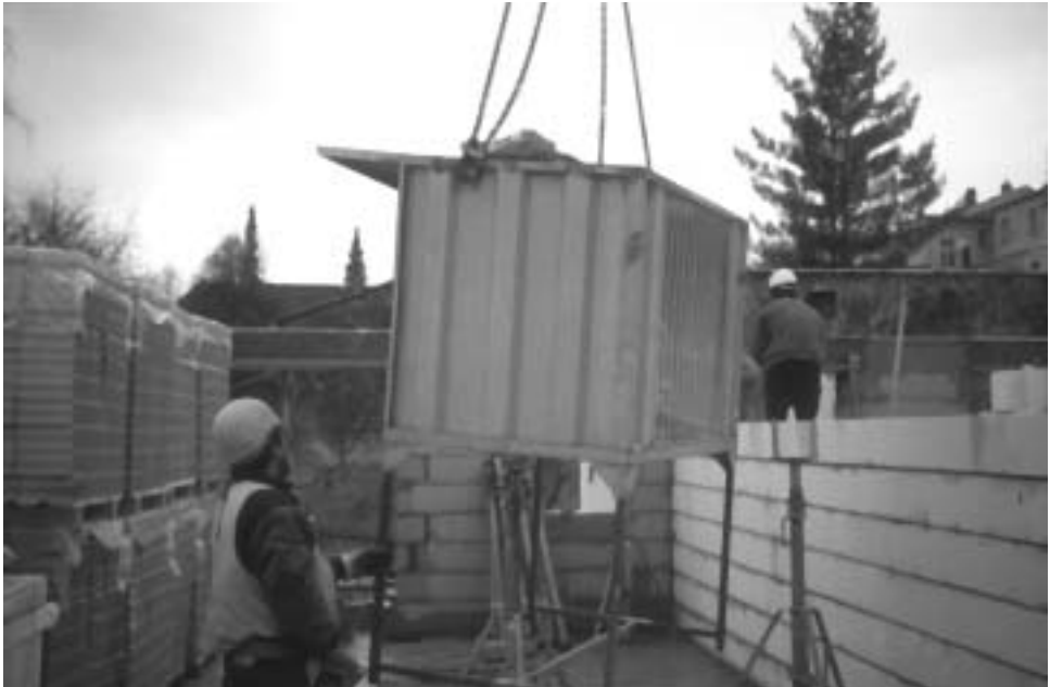
Abbildung 30: Turmdrehkran fernsteuern (B 20)
