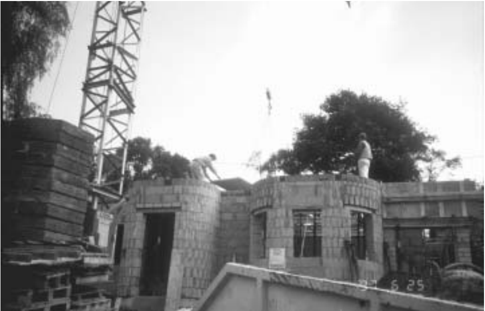
Abbildung 37: Filigrandeckenteile der Erdgeschossdecke verlegen (B 29)
