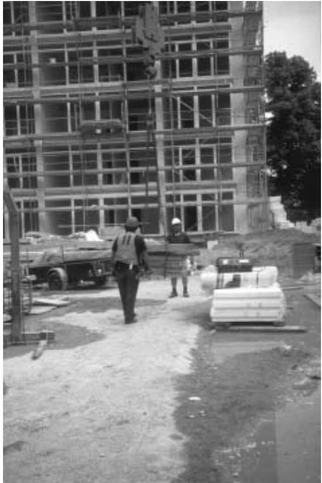
Abbildung 41: Schalmaterial mit ferngesteuertem Turmdrehkran transportieren (B 33)
