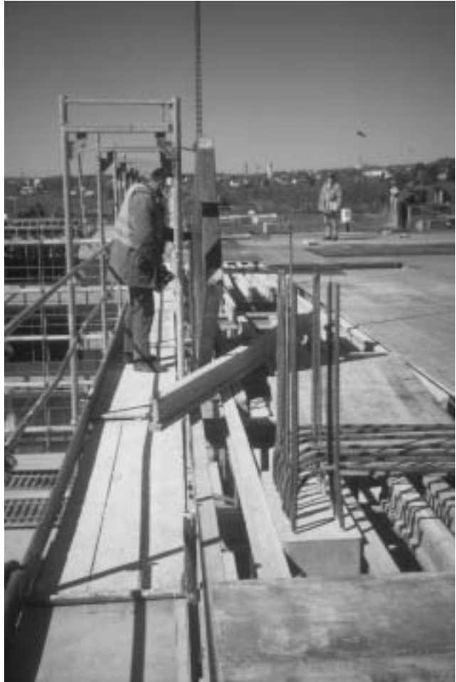
Abbildung 32: Schalelement zwischen Außen- fassade und Gerüst herausziehen (B 22)
