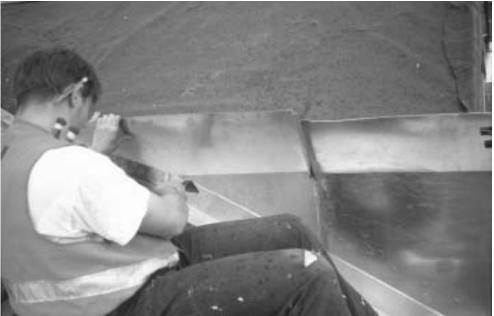
Abbildung 16: Gaube einblechen (A 7)
