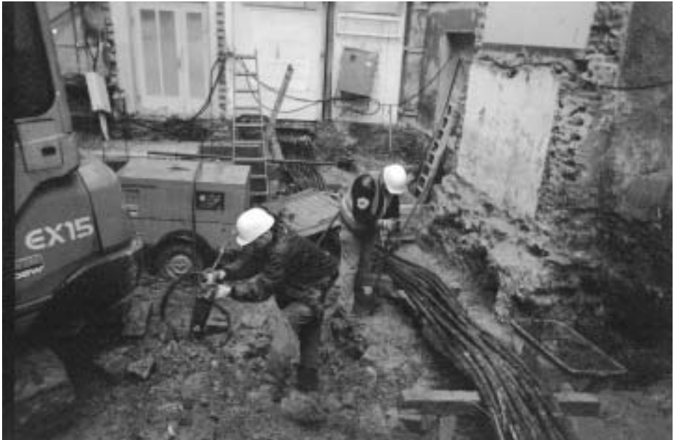
Abbildung 28: Elektrokabel aus dem Baggerbereich des Minibaggers verlegen; Arbeit in der Nähe von Minibagger, Kompressor und Aufbruchhammer (B 18)
