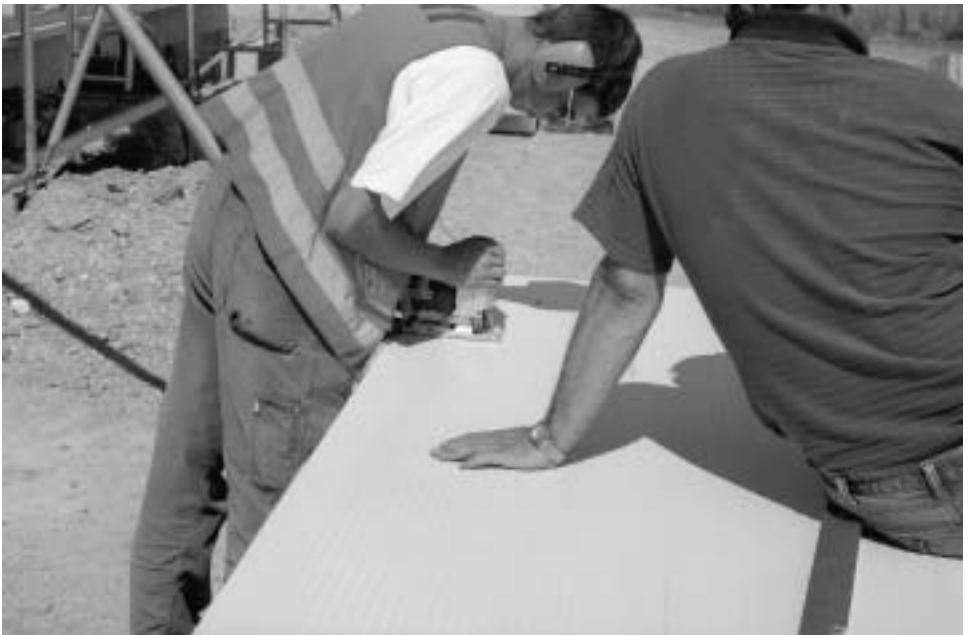
Abbildung 33: Aluminium-Profilplatten sägen (A 33)
