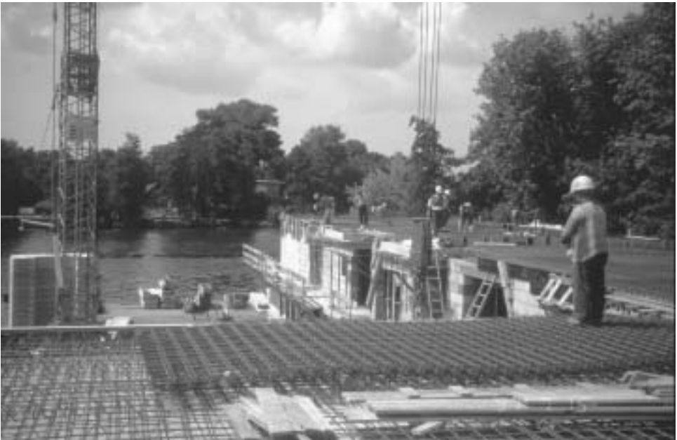
Abbildung 40: Montiereisentransport mit ferngesteuertem Turmdrehkran (B 32)
