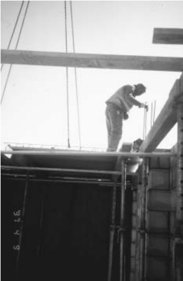
Abbildung 33: Filigrandeckenplatten verlegen (B 24)
