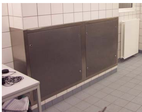
Abbildung 6: Beispiel für einen vor der Wand angebrachten Flächenluftdurchlass
