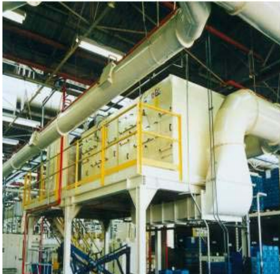
Abbildung 4: Beispiel für einen Aerosolnebelabscheider
