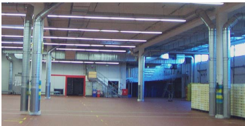
Abbildung 7: Positionierung der Quellluftdurchlässe
