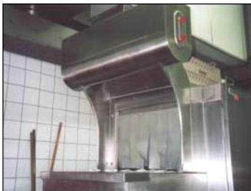
Abbildung 13: Beispiele für Wirbelhauben an Spülmaschinen
