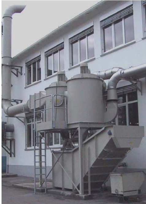
Abbildung 7: Nassetstaubungsanlage zur Abscheidung von Schleifstaub bei der Bearbeitung von Aluminium- und Magnesiumlegierungen
