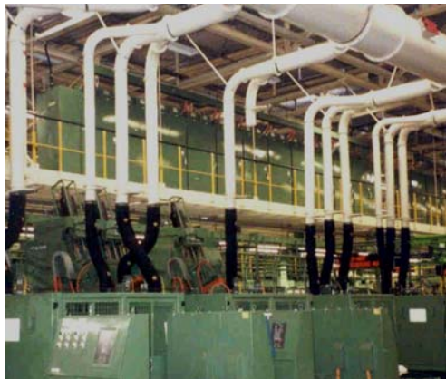
Abbildung 1: Absauganschlüsse an vollständig gekapselten Werkzeugmaschinen
