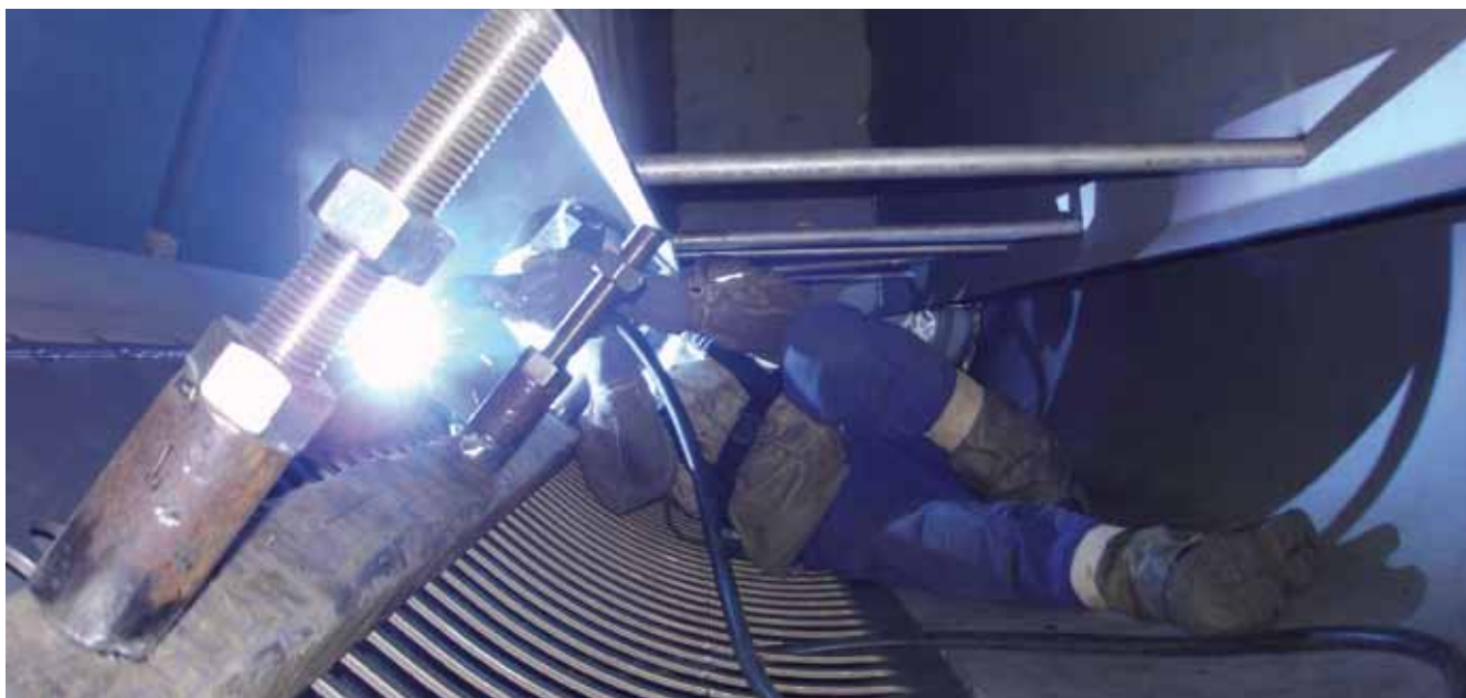
Beim Innenausbau der Maschinen müssen die Schweißer häufig auf engem Raum arbeiten. Um die gesundheitliche Belastung zu senken, hat Krones eine Reihe von Maßnahmen durchgeführt – mit Erfolg.
