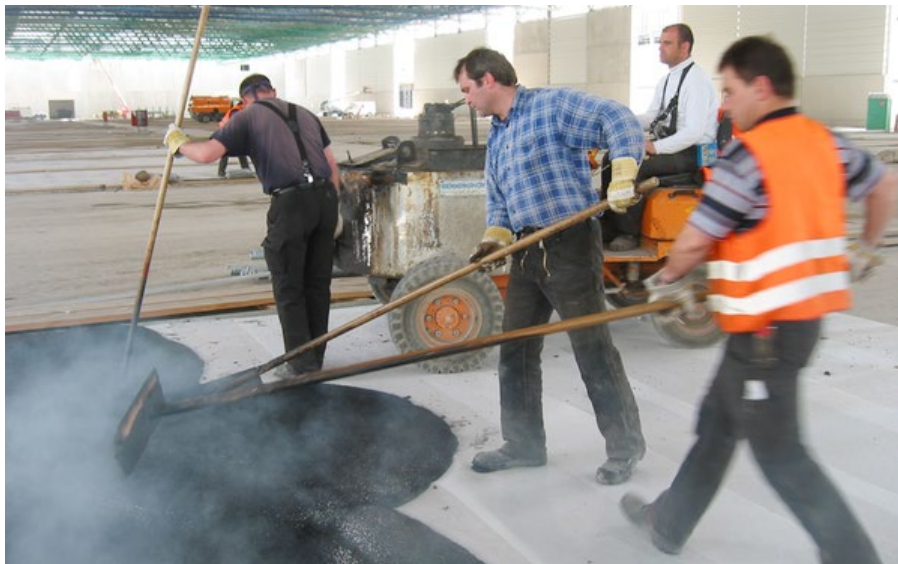
Beschäftigte tragen eine bitumenhaltige Asphaltdecke auf.
